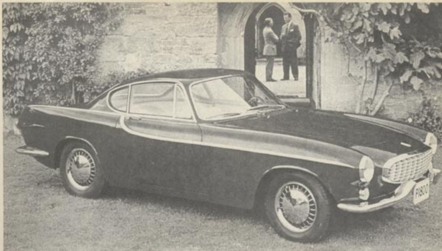
Typische äußere Erkennungszeichen der ersten Serie sind „Kuhhorn-Stößtangen“, „Eierkartongrill“ und Volvozeichen mit Schwedenflagge auf der C-Staue.
