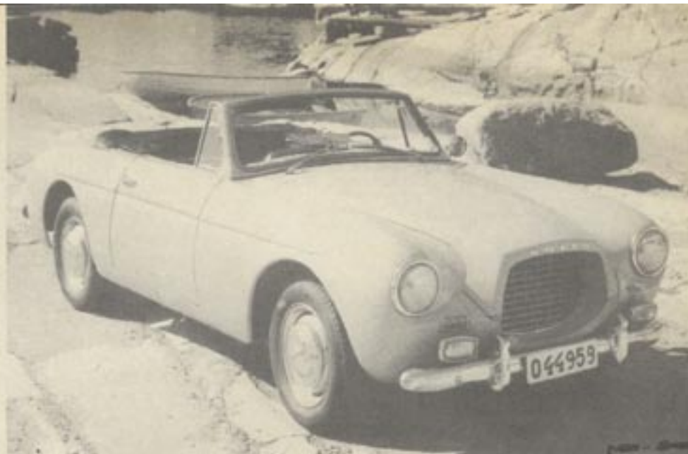
Das Vorgängermodell P 1900 basiert auf der Mechanik des PV 444 und besitzt eine Karosserie aus dem Experimentierwerkstoff der 50er Jahre: Kunststoff.
